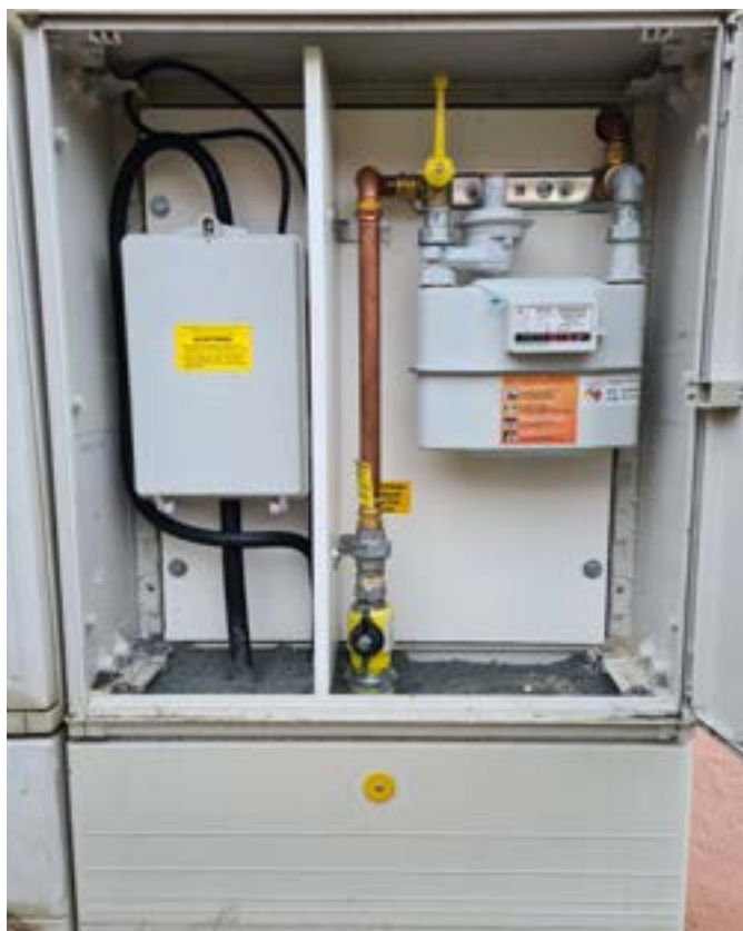
Beispiele Anschluss-Schrank (Strom, Gas)
